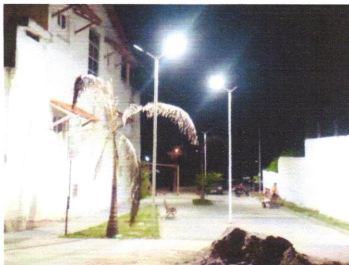
FOTO 06 - LUMINARIA EM LED PARA ILUMINAÇÃO PÚBLICA, 302, BIVOLT, SELO A INMETRO, CORPO EM ALUMINIO
