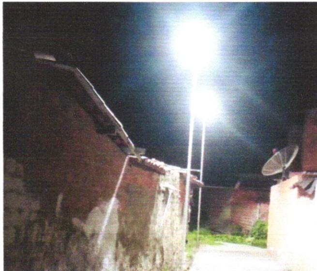
FOTO 05 – LUMINARIA EM LED PARA ILUMINAÇÃO PÚBLICA, 302, BIVOLT, SELO A INMETRO, CORPO EM ALUMINIO
