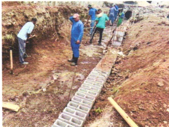
FOTO 02 – ALVENARIA DE VEDAÇÃO DE BLOCOS VAZADOS DE CONCRETO DE 9X19X39CM (ESPESSURA 9CM DE OAREDES COM ÁREA LIQUIDA MAIOR OU IGUAL A 6M2
