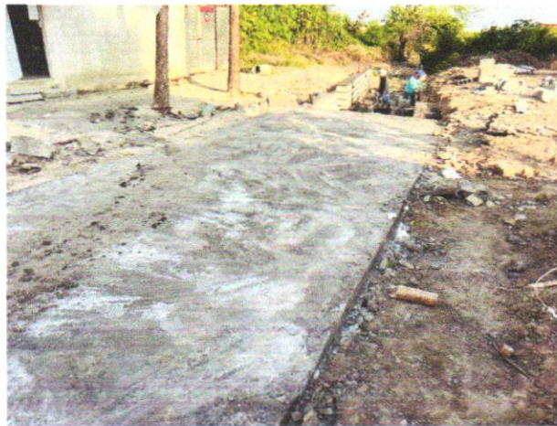
FOTO 01 – PISO EM CONCRETO 20MPA PREPARO MECÂNICO . ESPESSURA 7CM..
