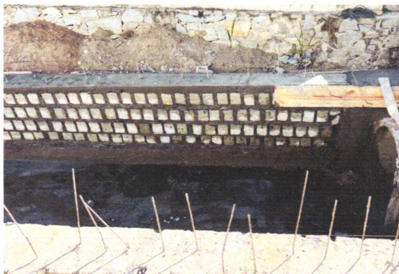
FOTO 08 - ALVENARIA DE VEDAÇÃO DE BLOCOS VAZADOS DE CONCRETO DE 9X19X39CM (ESPESSURA 9CM DE OAREDES COM ÁREA LIQUIDA MAIOR OU IGUAL A 6M2
