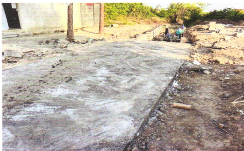
FOTO 04- PISO EM CONCRETO 20MPA PREPARO MECÂNICO . ESPESSURA 7CM..
